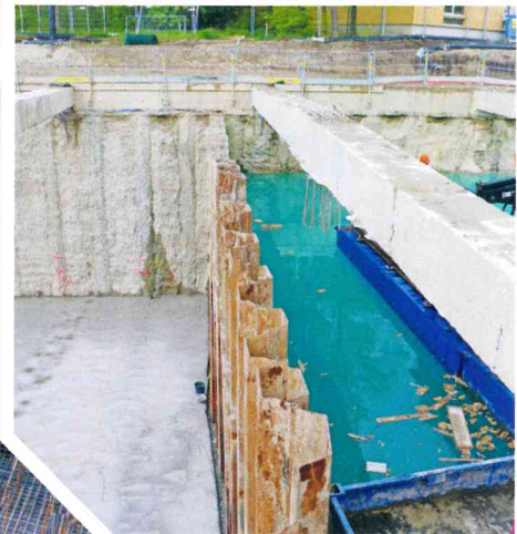
In den Bereichen im Baulos 3, in denen das Grundwasser bereits abgepumpt werden konnte, läuft der Ingenieurbau bereits auf Hochtouren. Rechts die Spundwand zwischen Schott 8 und 9.
