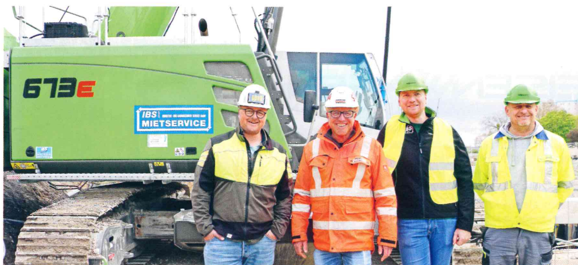
Der Telekran 673 E ist eine wichtige Unterstützung für den Ingenieurbau im Baulos 3 (von links): Roland Schelch (PORR, Bauführer der Baulose 3 + 4), Mario Hofer (STRABAG, Polier Baulos 3), Joseph Warum (Leiter der Niederlassung IBS Austria) und Soltan Szüsz (PORR, Maschinist des Sennebogen 673 E).
