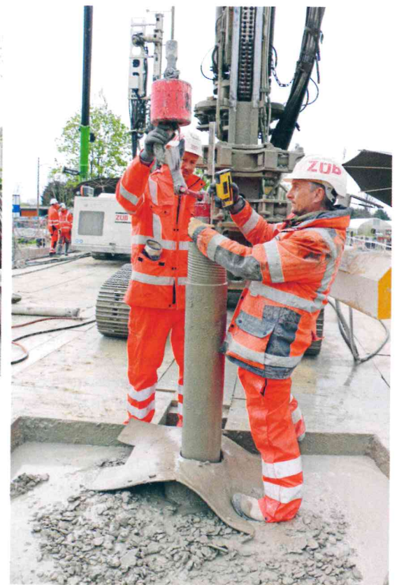
Hermann Fockberger (rechts) und Karl Heinz Warmuth von der Firma Züblin Spezialtiefbau beim Nivellieren des Auftriebsankers.
